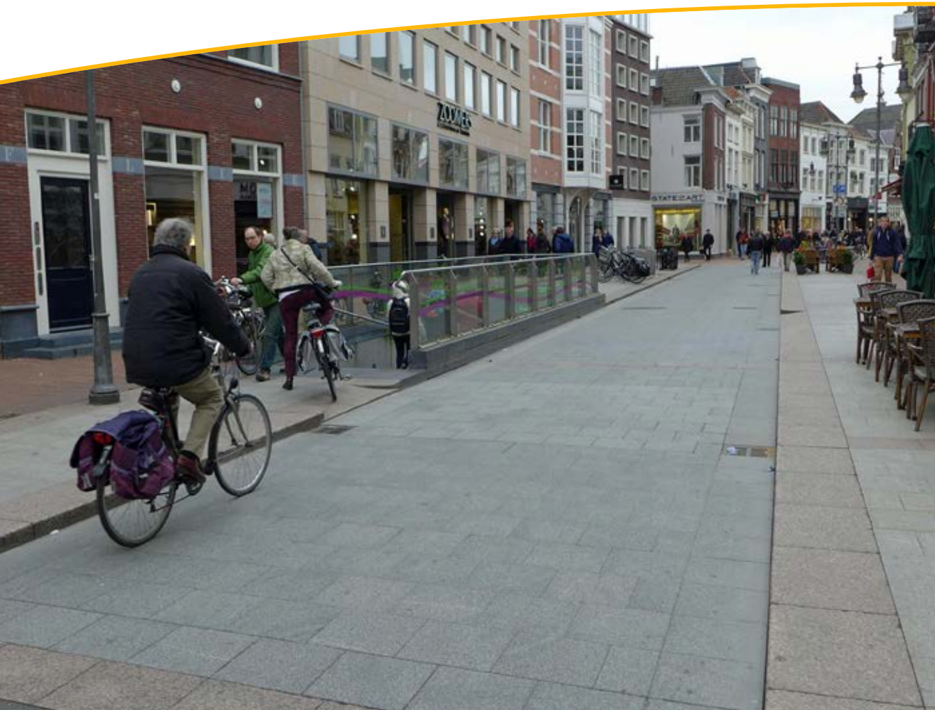
De overgang naar het trottoir is schuin gemaakt
