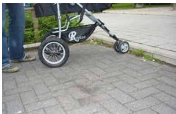
Kleine hoogverschillen vormen al een belemmering
