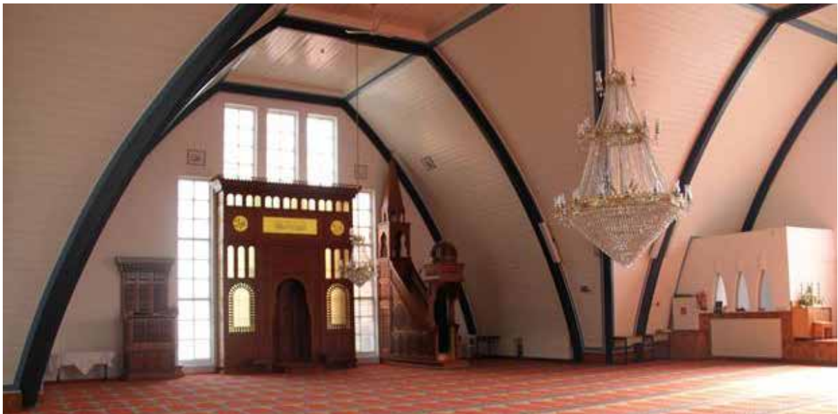
Foto van het interieur van de Moskee Mescid-I-Aksa, voormalige Noorderkerk, Royaards van den Hamkade, herbestemd in 1995. Door middel van een extra vloer en trappenhuis in de hoge kerkzaal is een nieuwe gebedsruimte gemaakt voor de Turkse Islamitische gemeenschap. De oorspronkelijke houten kap met ribben blijft goed zichtbaar.
