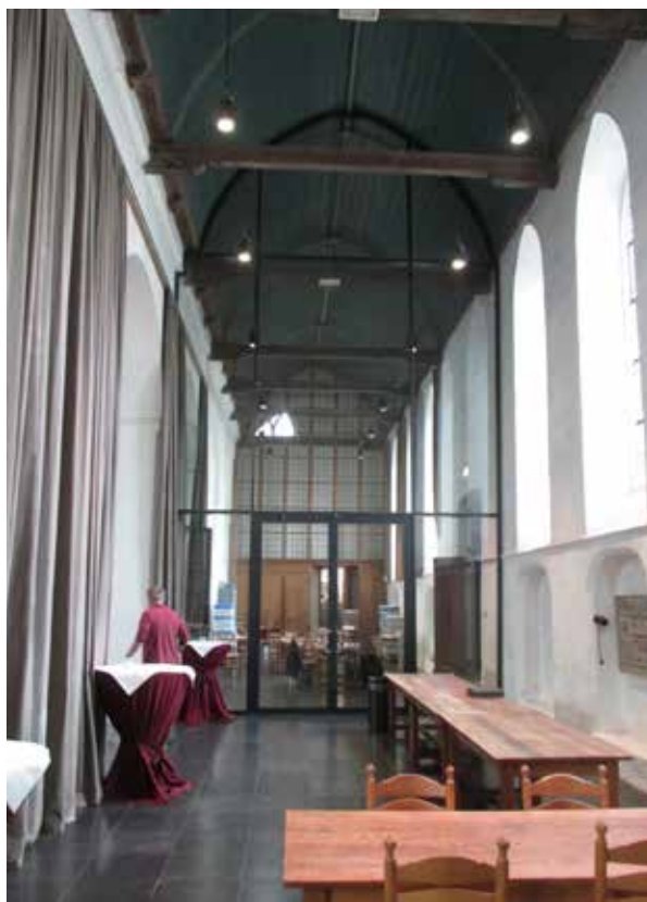
Foto van het interieur van de Geertekerk met nieuwe glazen pui uit 2016 in een zijbeuk voor multifunctioneel gebruik.
