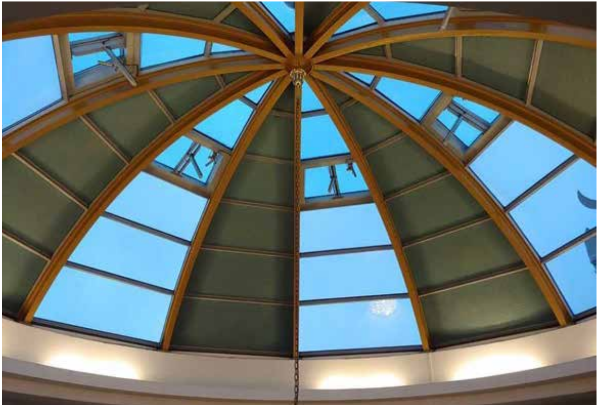
Foto van het interieur van de Abi Bakr Essadik moskee, Berlagestraat, Zuilen: te zien is de grote koepel in de centrale gebedsruimte, de kap bestaat afwisselend uit gesloten gedeelten en gedeelten met glas.
