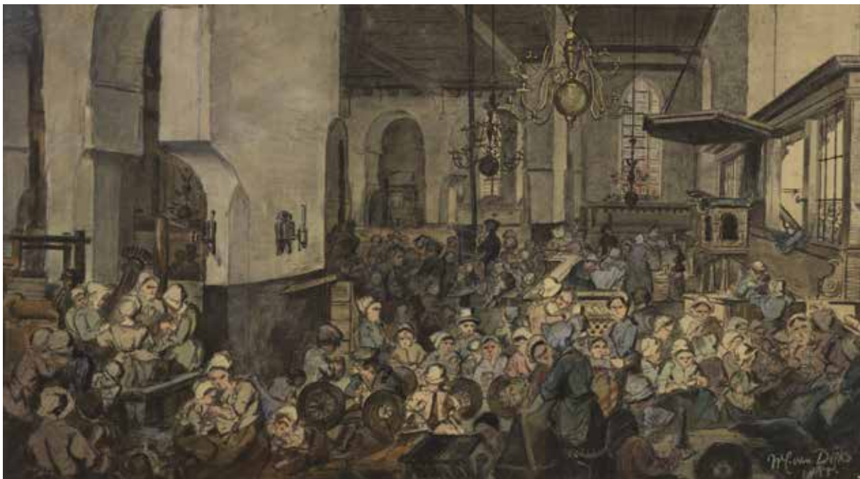
Tekening van het interieur van de Geertekerk te Utrecht, ingericht als opvangcentrum voor watersnoodvluchtelingen uit Veenendaal in 1855, gemaakt door W.C. van Dijk. Te zien is een kerk vol vluchtelingen. (HUA)
