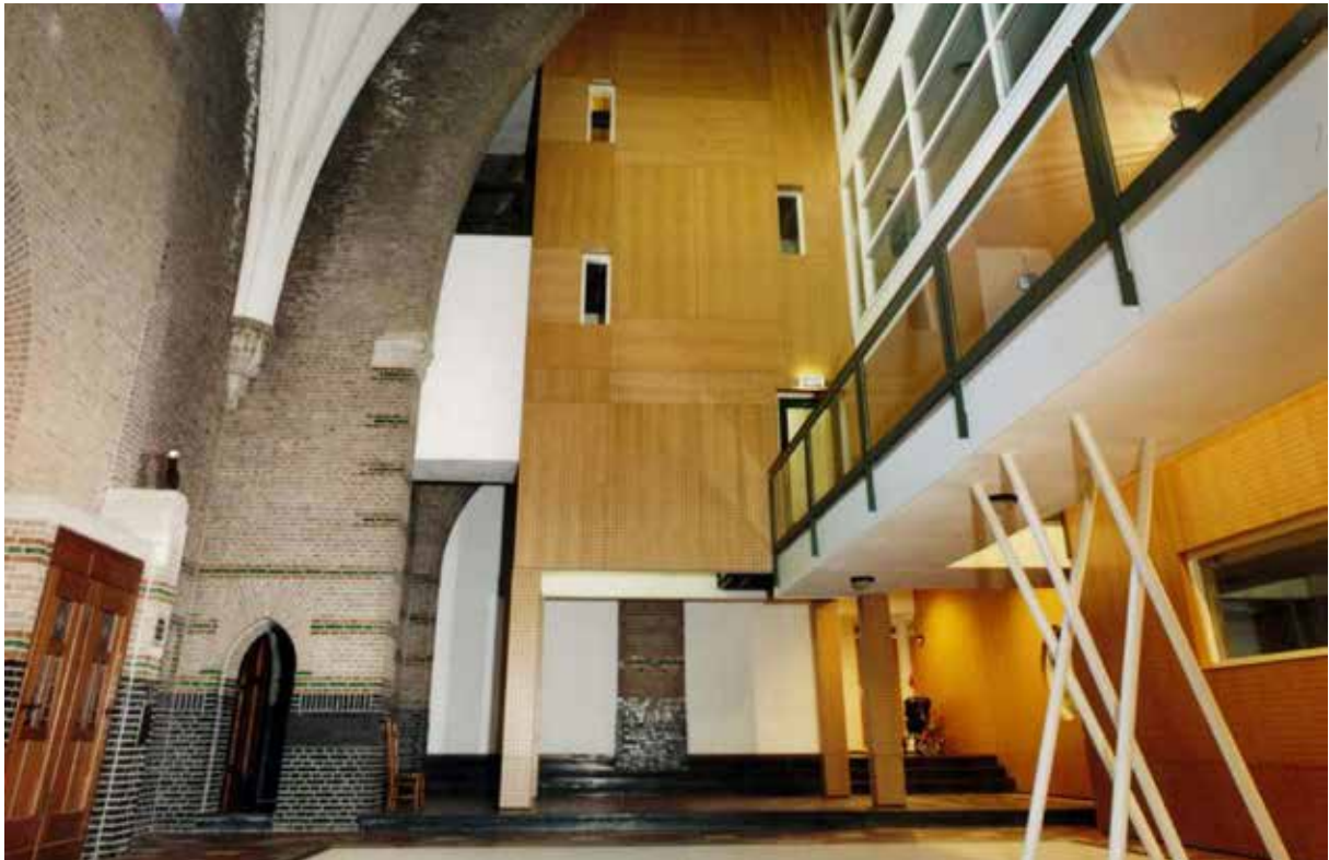
Foto van het interieur van de Heilig Hartkerk in Oudwijk (appartementen), herbestemd 1998-1999. Door de gemeenschappelijk entree en de ontsluiting van de appartementen (lift en galerijen) vorm te geven als een losstaand 'meubel', blijft de hoogte van de oorspronkelijke kerkzaal te ervaren. Daarentegen vereisten de appartementen grote ingrepen in de gesloten buitengevels en het dak. (Plegt-Vos b.v.)
