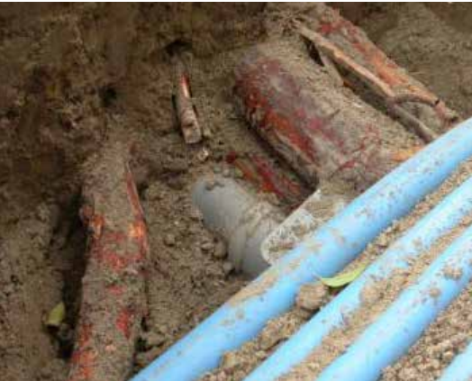
Afb. 4.05 (links) Beperkte wortelgroei door bekabeling. Afb. 4.06 (midden) en 4.07 (rechts) Voorbeelden van wortel-opdruk.
