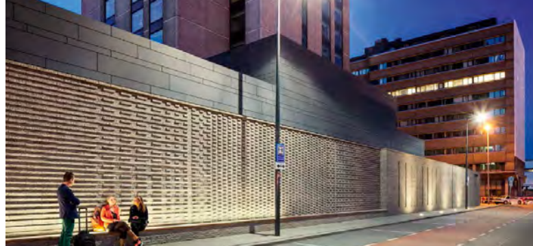
De architectuur is rijk in zijn materialisatie en detaillering. De wandafwerking na sloop parkeergarage aan NH hotel.
