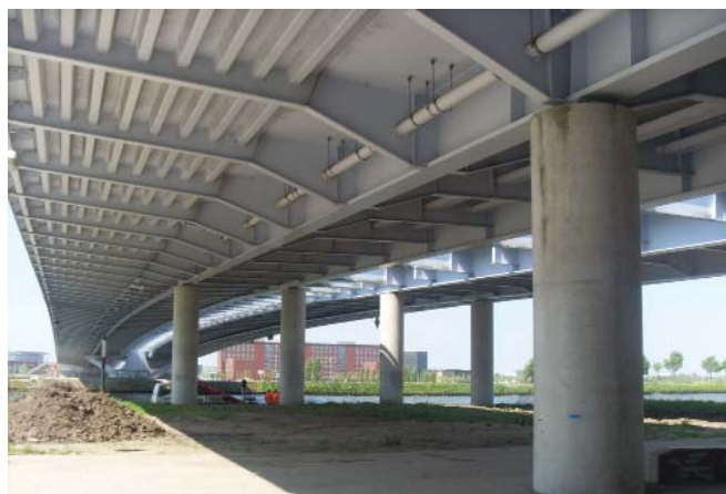
Wereld onder de Prins Clausbrug, Kanaleiland
