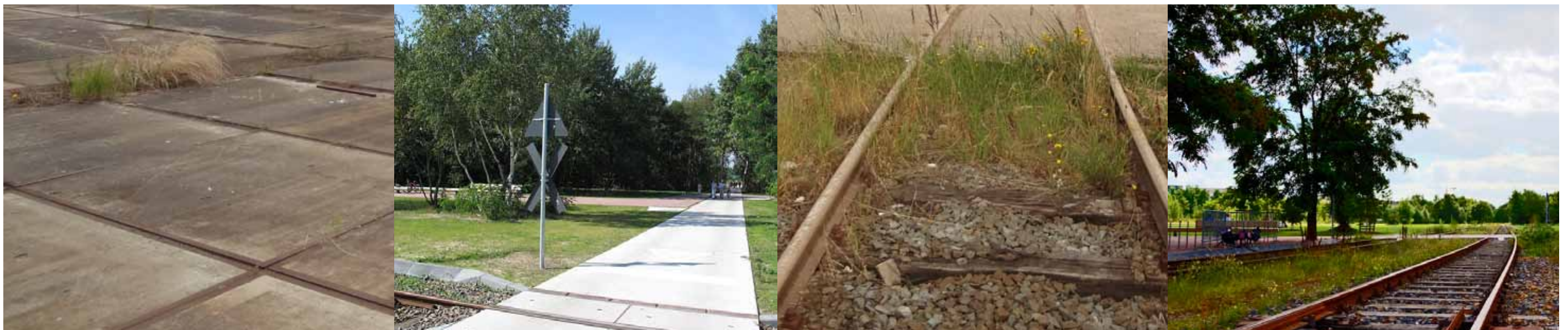
hergebruik aanwezige beeldbepalende materialen; stelconplaten, bielzen, rails
