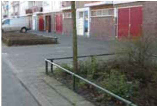
Openbare binnenstraat: Renovatie plantvakken
