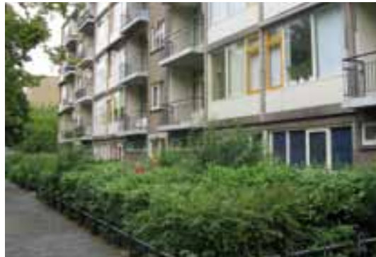
Openbare binnenstraat: Renovatie plantvakken
